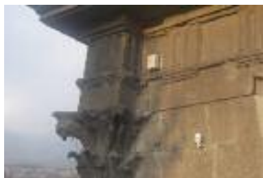
Fig. 1. Arco di Augusto, Aosta: monitoraggio microclimatico e strutturale con unità Grillo connesse a OLINDA*
